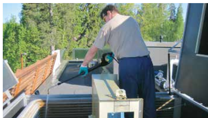
McDonald's'in keittiön LTO-huippuimurin (ilmavirta 2,4 m 3 /s) huolto. LTO-huippuimuri on ihanteellinen ratkaisu ammatti-keittiöihin.
