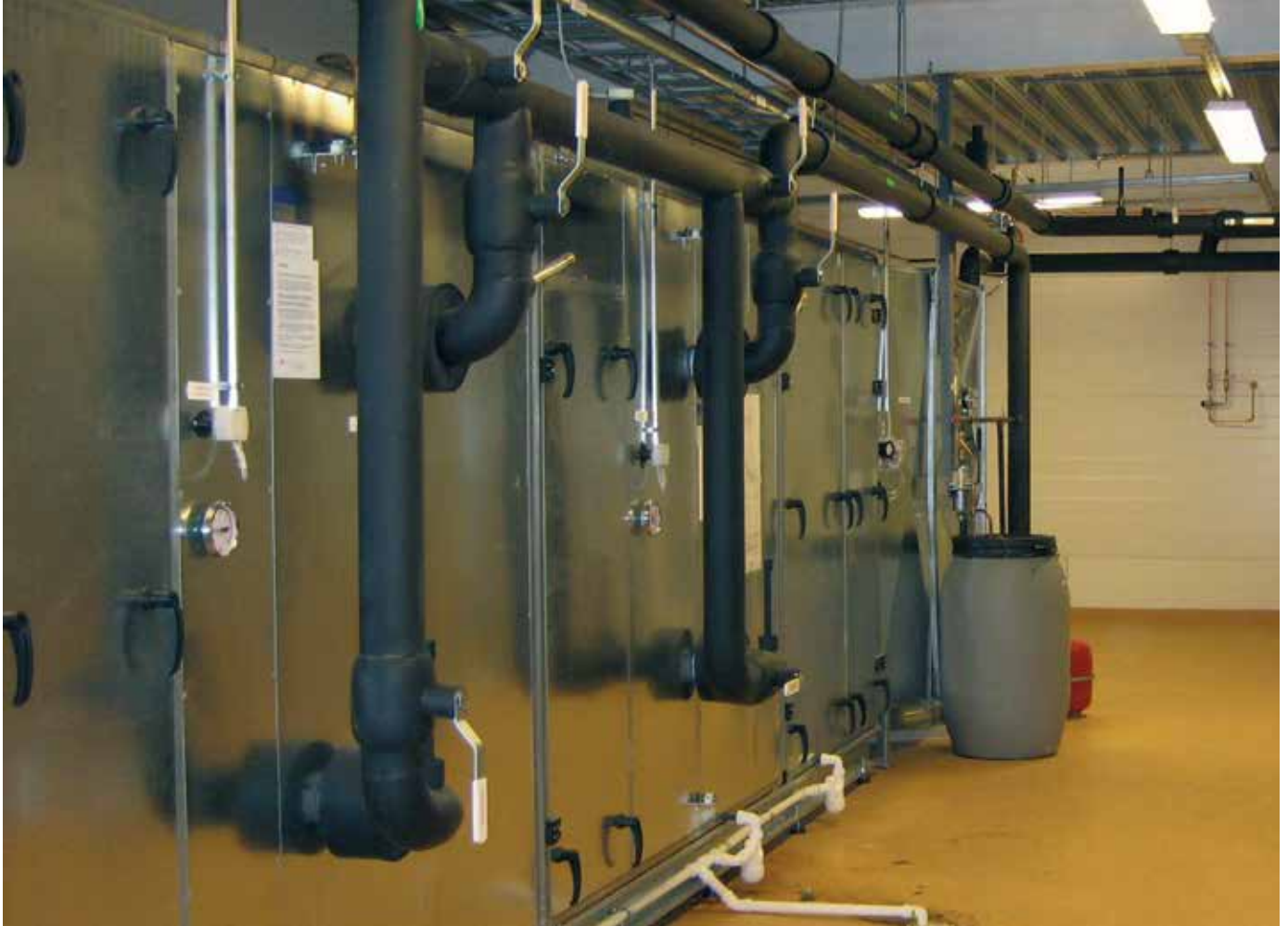
RETCARE MODULAR -poistoilmakone, jonka mitoitusilmavirtaama on 7 650 l/s. Koneessa on kaksilohkoinen LTO-neulälämmönsiirrin, jonka huolto tapahtuu huolto-osien kautta.
