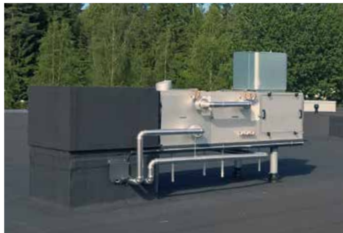
RETCARE OUT E -poistoilmakone asennettuna vesikatolle jalustan päälle.
