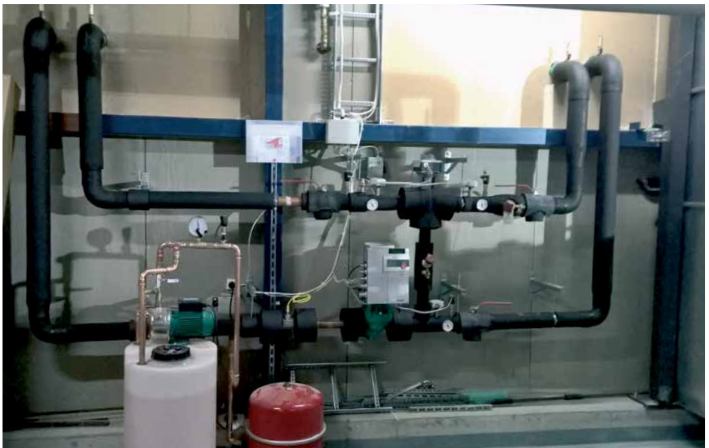
Retermia-toimilaitepaketti ilmanvaihdon LTO-piiriin. Putkilähdöt sivulle, liuosvirtaama 1,55 l/s.
