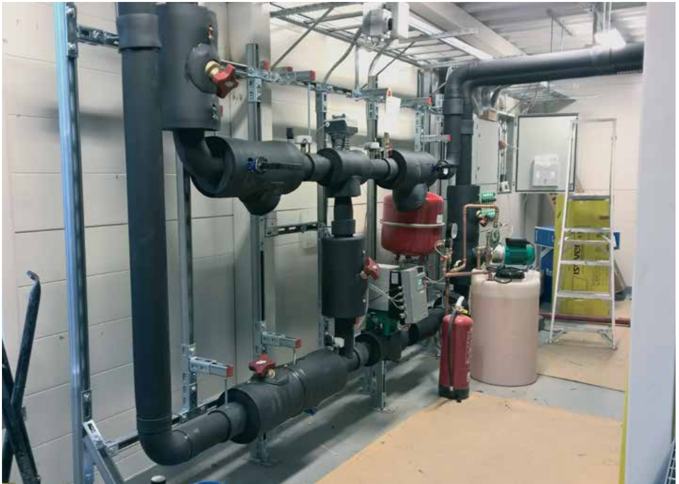
Retermia-toimilaitepaketti ilmanvaihdon LTO-piiriin. Putkilähdöt sivulle, liuosvirtaama 2,2 l/s.
