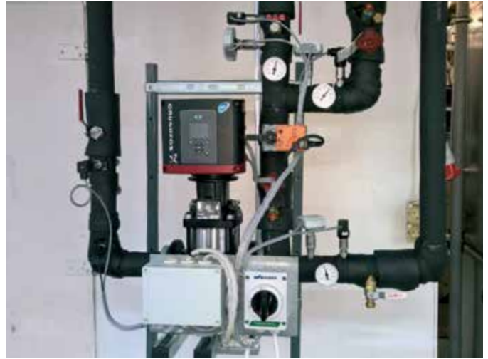
Retermia-toimilaitepaketti ilmanvaihdon LTO-piiriin. Putkilähdöt ylös, liuosvirtaama 0,35 l/s.
