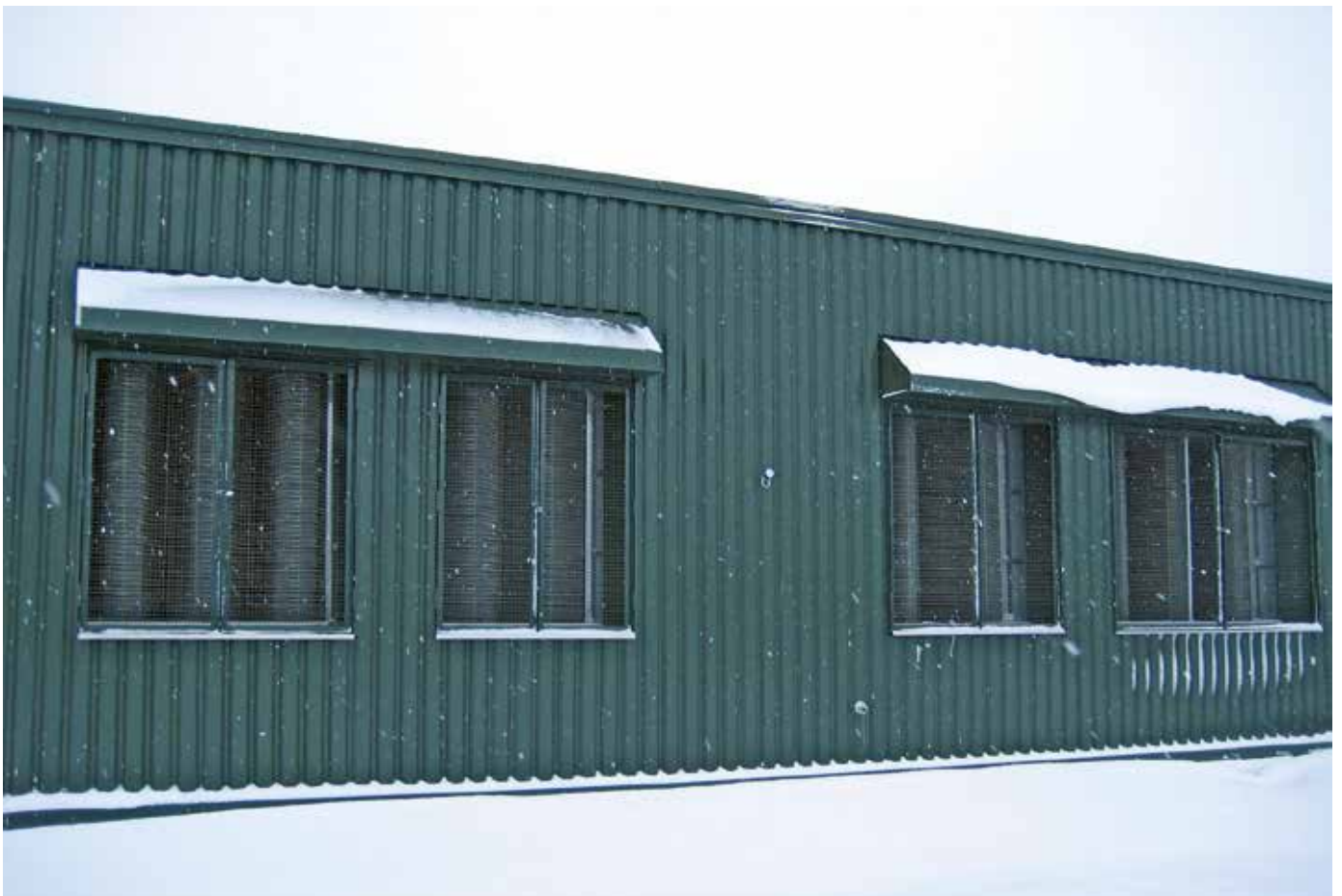
Neulälämmönsiirtimet Valio Oyj Haapaveden tehtaan ilmanvaihtokonehuoneen ulkoseinällä.
