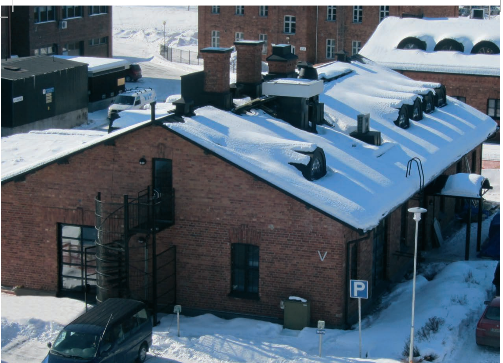
Mikkelin ammattikorkeakoulun hallintorakennuksen passiivijärjestelmä, jossa tuloilman esilämmitys ja jäähdytys on toteutettu vesikatolla sijaitsevalla ilmanottokotoksella. Passiivijärjestelmää hyödynnetään myös tutkimus- ja opetuskäytössä.
