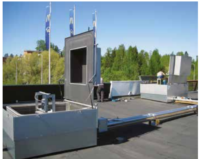
Ravintolasalin LTO-huippuimuri kuvassa vasemmalla ja keittiötilan LTO-huippuimuri oikealla huoltokannet avattuna.
