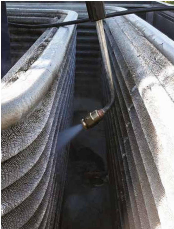
Neste K -huoltoasemalla sijaitsevan Burger King -ravintolan rasvahuuvan LTO-huippumurin pesua.
