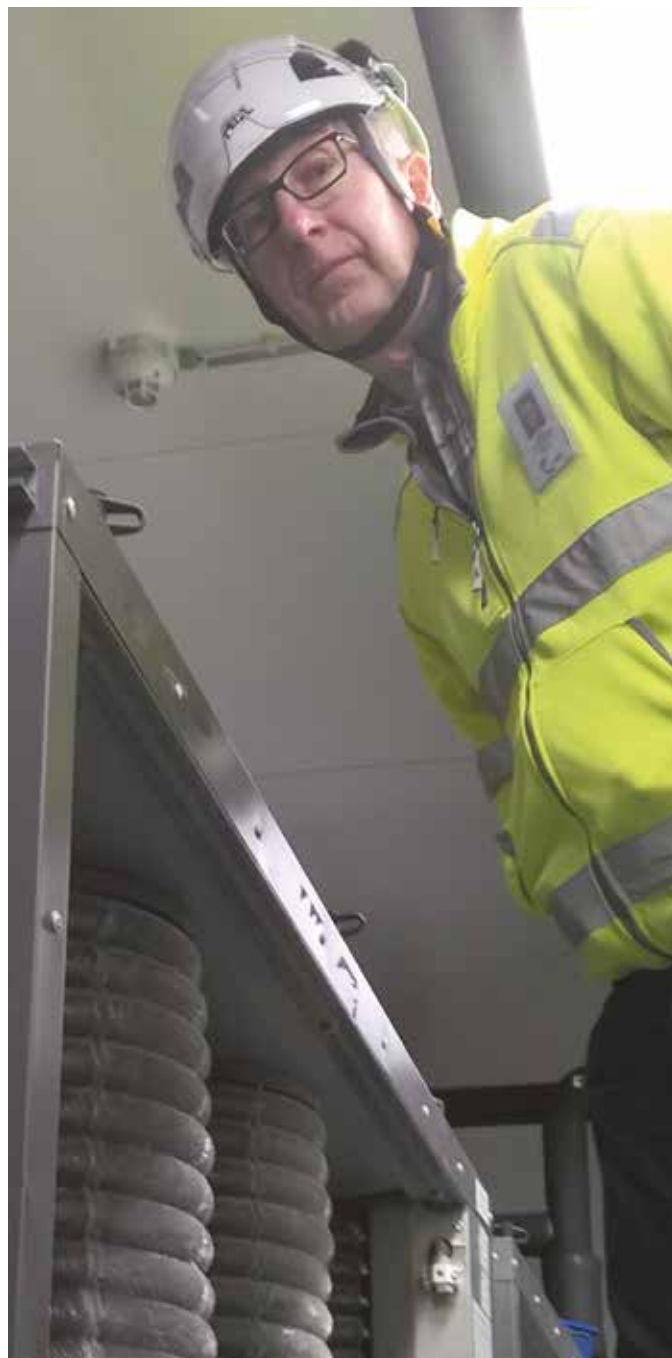
KYS:in kiinteistöhallinnon LVIA-asiantuntija Kari Laukkanen sanoo, että projektissa haettiin eri ratkaisusta vertailutietoa jo suunnitteluvaiheessa.
