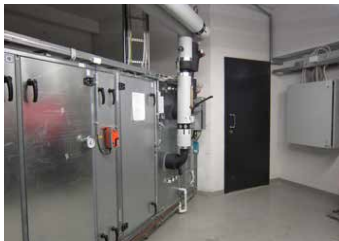
RETCARE MODULAR -tuloilmakone, jonka mitoitusilmavirtaama on 10 000 l/s. Tämän koneen LTO-neulalämmönsiirtimien huolto tapahtuu suodatinosan ja raitisilmakammion kautta.
