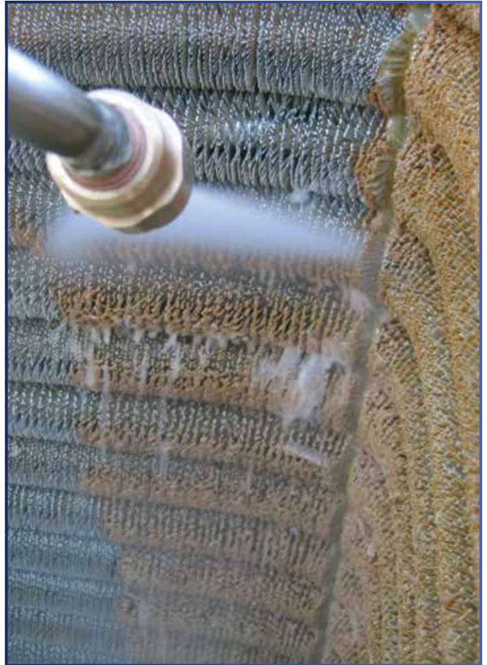
Kuva 8. LTO-huippumurin sisällä on tila huoltohenkilölle ja pohjavati kestää huoltohenkilön painon. Retermian LTO-laitteet on varustettu huoltokansilla, vesitiiviillä pohjavadilla sekä useilla pesu- ja kondenssivesiviemäreillä. Poistoilmakanavisto päästään nuohoamaan LTO-huippumurin kautta kippaamalla poistopuhallin sivuun.
