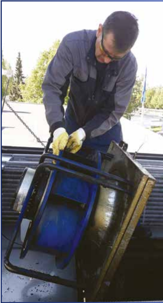
Kuva 8. LTO-huippumurin sisällä on tila huoltohenkilölle ja pohjavati kestää huoltohenkilön painon. Retermian LTO-laitteet on varustettu huoltokansilla, vesitiiviillä pohjavadilla sekä useilla pesu- ja kondenssivesiviemäreillä. Poistoilmakanavisto päästään nuohoamaan LTO-huippumurin kautta kippaamalla poistopuhallin sivuun.
